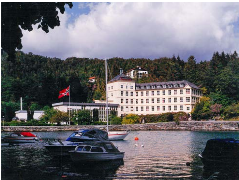
Kysthospitalet etter ombyggingen i 1972–73. De to eldste trebygningene ble revet og erstattet med en ny servicefløy.
