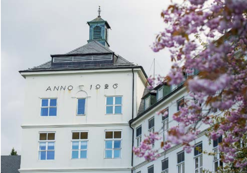
Hovedbygningen fra 1926 med sitt karakteristiske tårnhus gjør tjeneste fremdeles.
